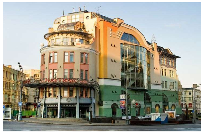
Торговый центр «Наутилус», Москва
